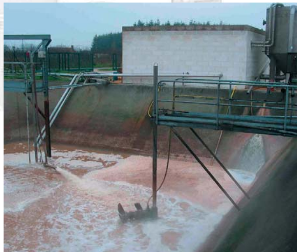
Kombineret system med neddykkelig AirJet og omrører i udligningstank på en konservesfabrik
