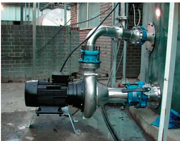
Tørtopstillet AirJet i beluftningstank på garveri
