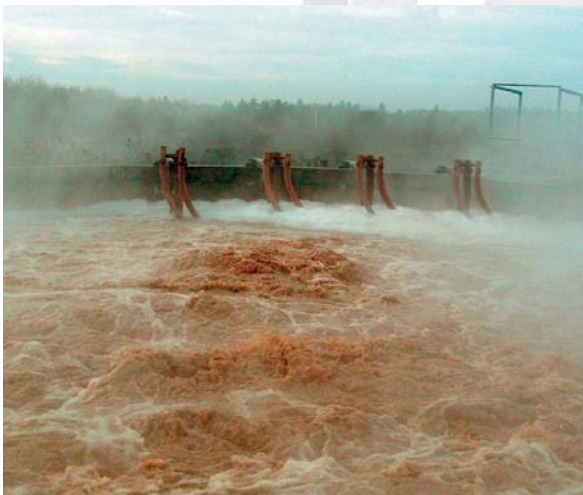
Neddykkelige AirJets i beluftningstank på papirfabrik
