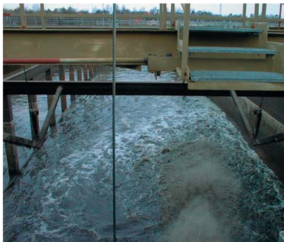
Rensning af bund i regnvandstank
