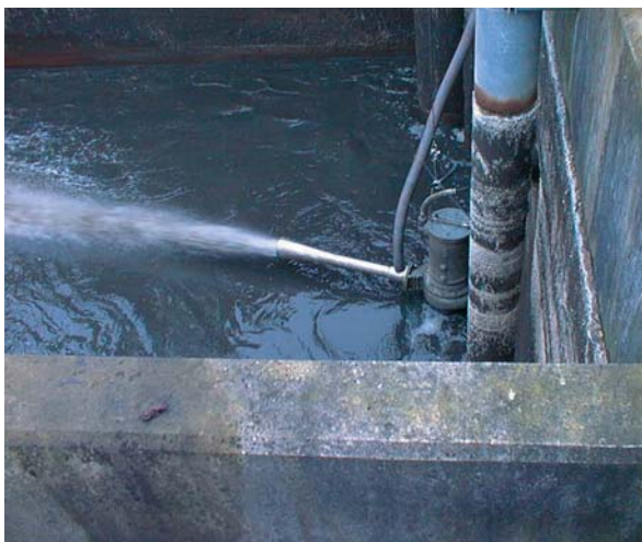
Rensning af bund i regnvandstank
