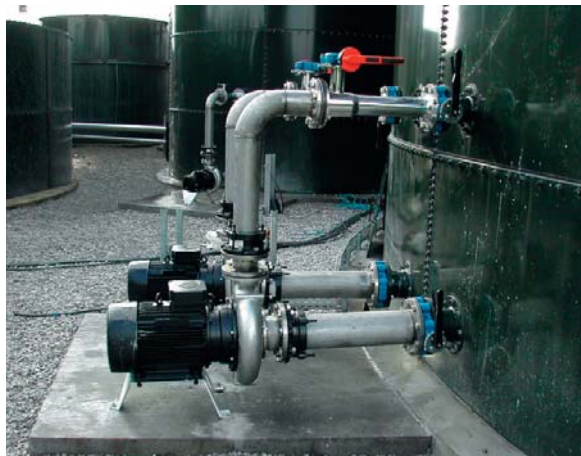
Tørtopstillede AirJets i beluftningstank på marmeladefabrik
