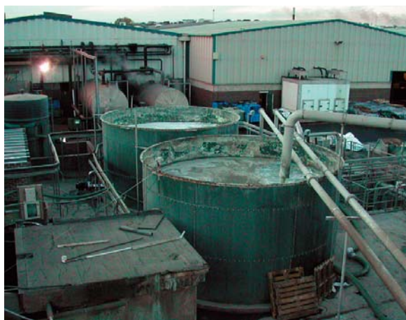
Tørtopstillet AirJet i beluftningstank på garveri
